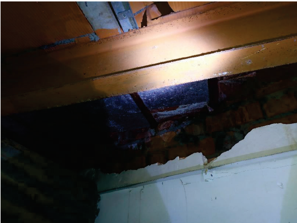
Foto: En pl. soterrani les dependències existents entre el mur de contenció del carrer i l'estructura estan cobertes amb petits forjats plans amb lloses de formigó armat encofrades i perfils metàl·lics recolzats al mur de contenció i a l'estructura.
