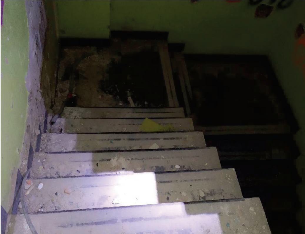
Foto: Les diferents plantes estan comunicades interiorment mitjançant una escala de 2 trams i un replà partit amb 2 graons, formada per una llosa de formigó amb graons d'obra.
