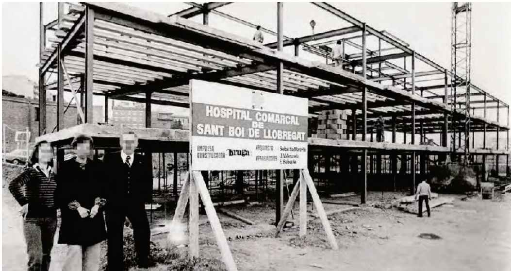
Foto: L'estructura durant la construcció de l'edifici. S'observa l'estructura metàl·lica portant i la disposició de les semibiguetes prefabricades de formigó armat al segon forjat.
