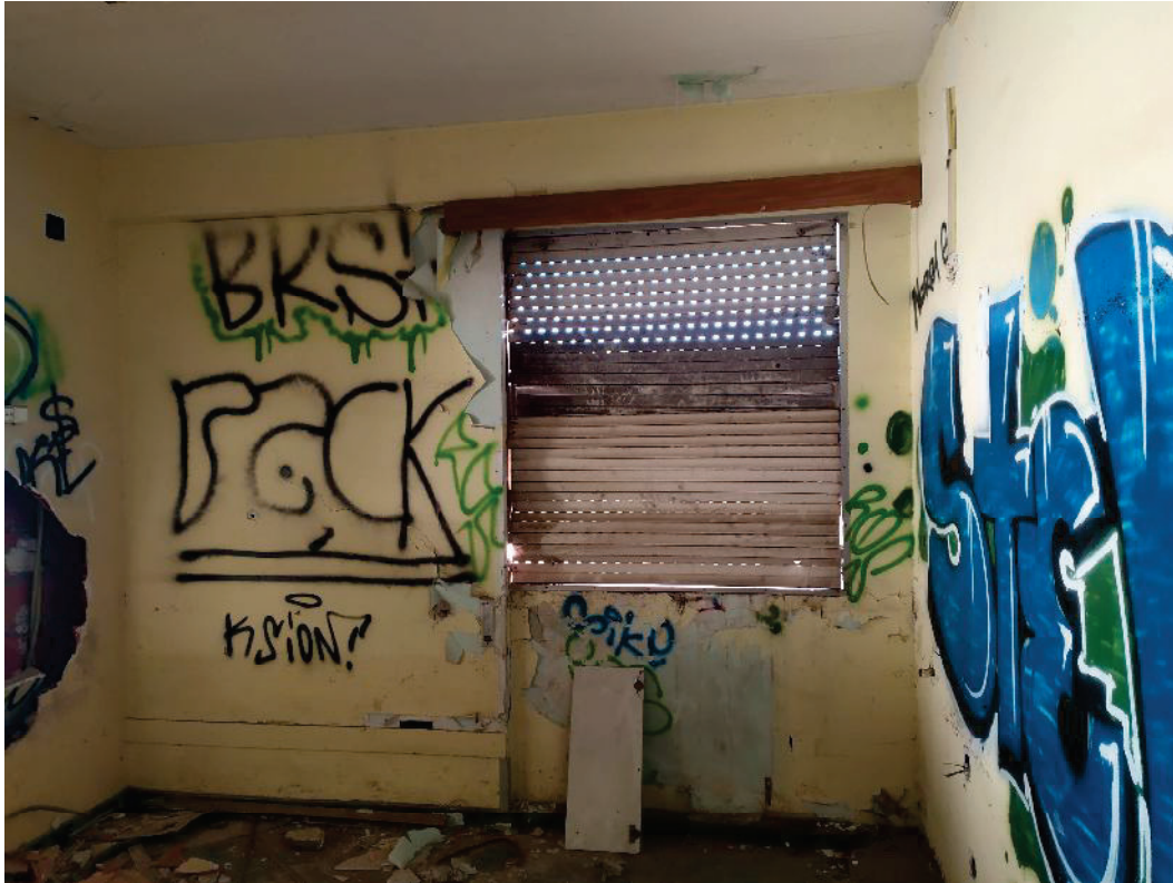
Foto: Algunes persianes enrotllables de PVC es mantenen però en un estat disfuncional i irrecuperable. (veure les fotografies següents)
